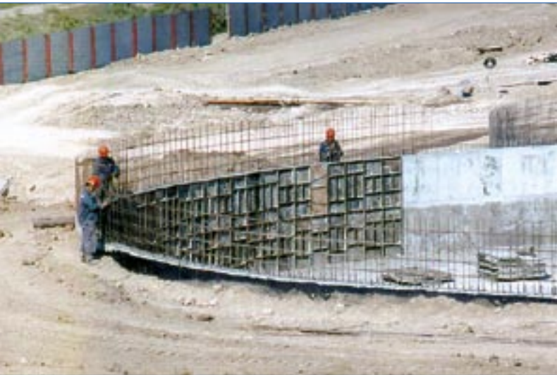
Рис.13. Строительство станции биологической очистки г. Кызылорда (Казахстан).
